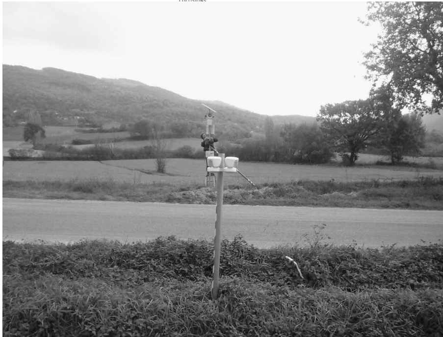
Σχήμα 3. Αισθητήρες PIR εγκατεστημένοι στον οδικό άξονα
