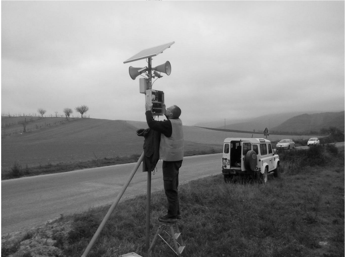
Σχήμα 5. Η εγκατάσταση της μονάδας ελέγχου στην άκρη της οδού.
