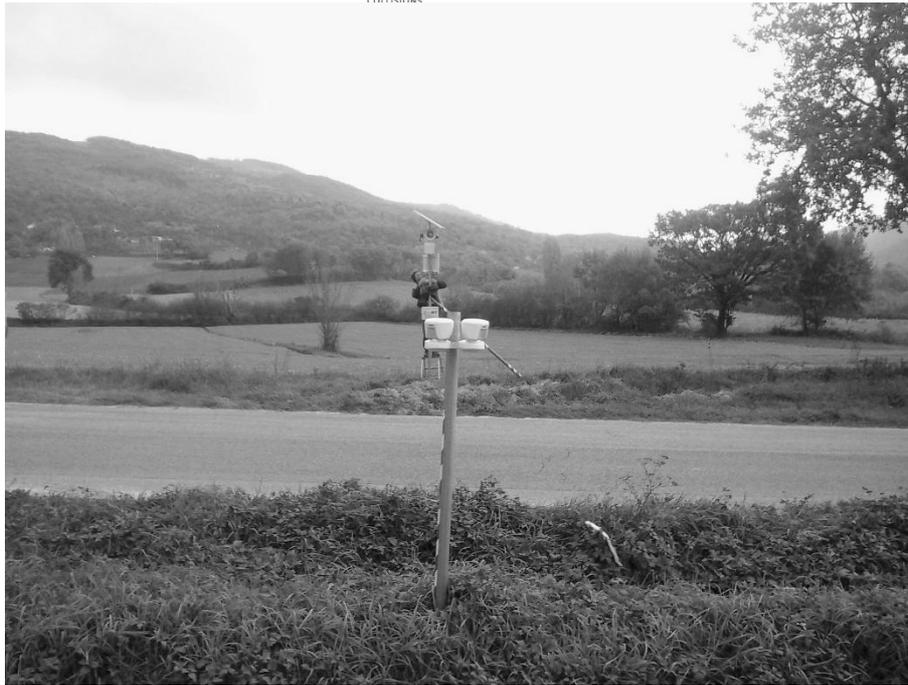
Σχήμα 3. Αισθητήρες PIR εγκατεστημένοι στον οδικό άξονα
