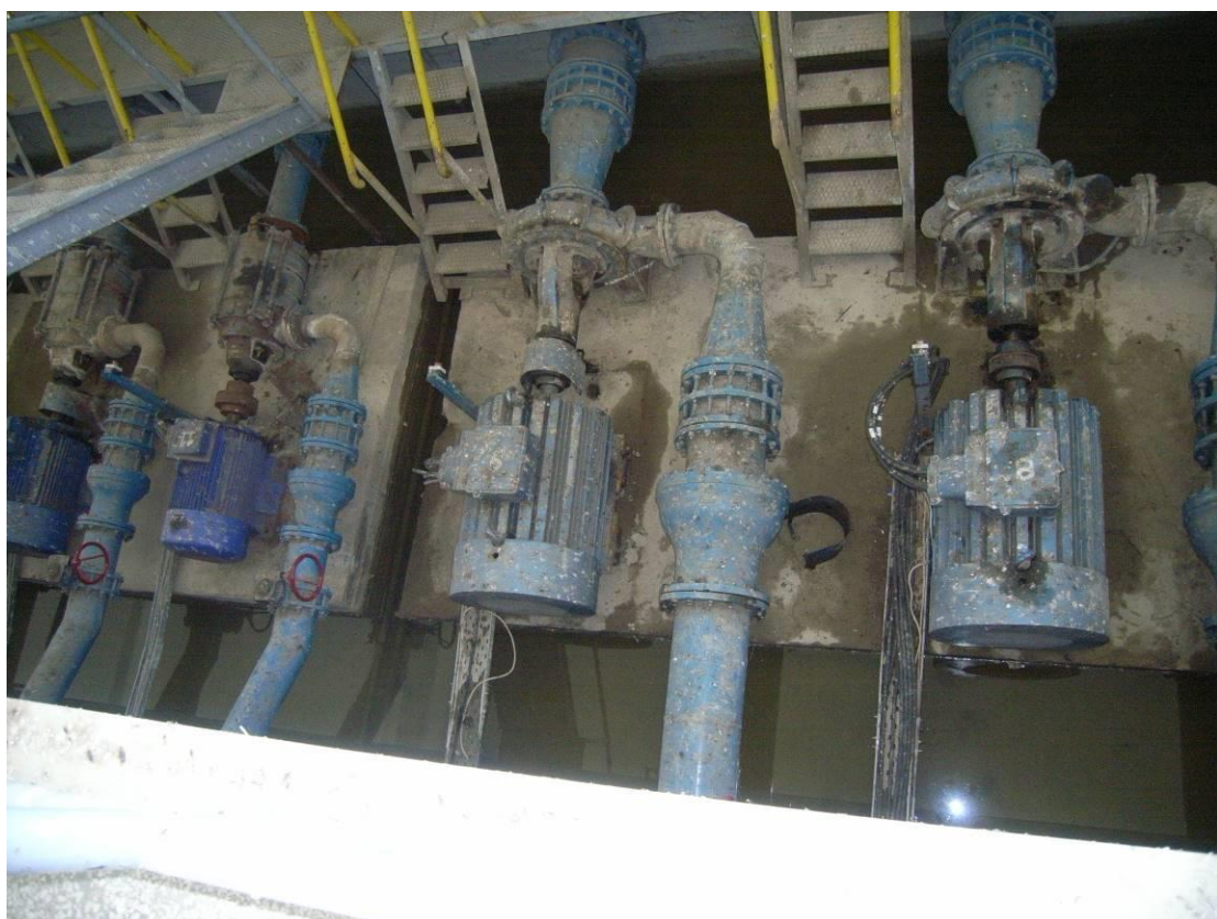
Φώτο 22 : Αντλητικά συγκροτήματα Ζώνης No 2 – κινητήρας αντλίας P2M-003 χωρίς καλώδια
