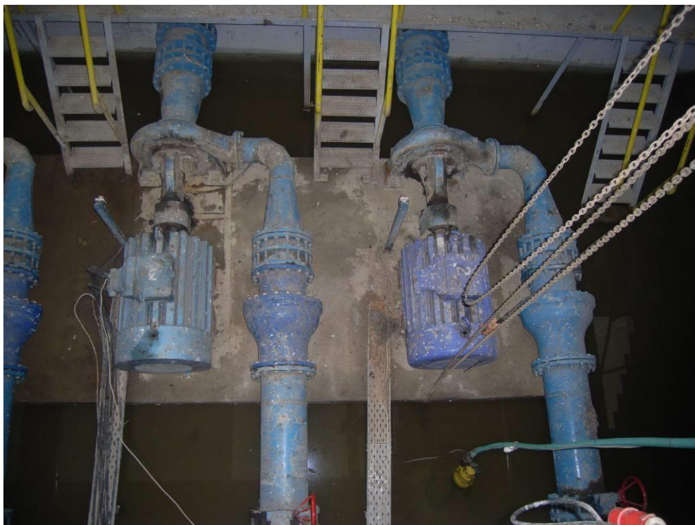
Φώτο 19 : Αντλητικά συγκροτήματα Ζώνης Νο 1 – «καμένος» κινητήρας αντλίας P1M-001 και χωρίς καλώδια
