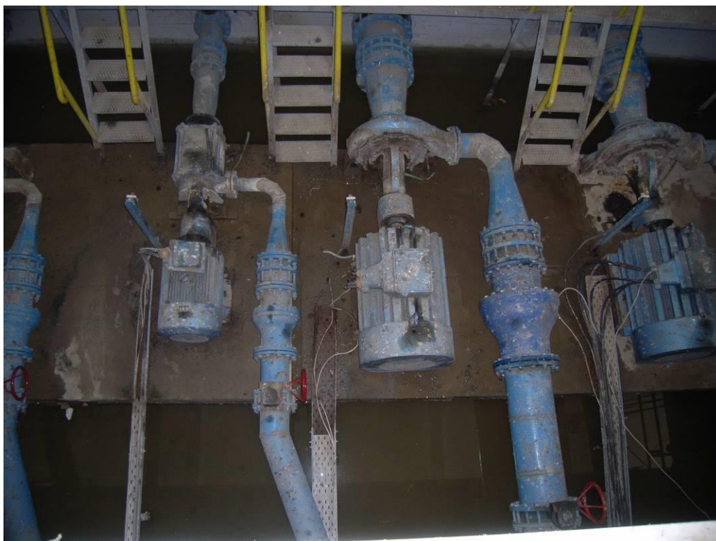
Φώτο 20 : Αντλητικά συγκροτήματα Ζώνης Νο 1 – «καμένος» κινητήρας αντλίας P1M-003 και χωρίς καλώδια
