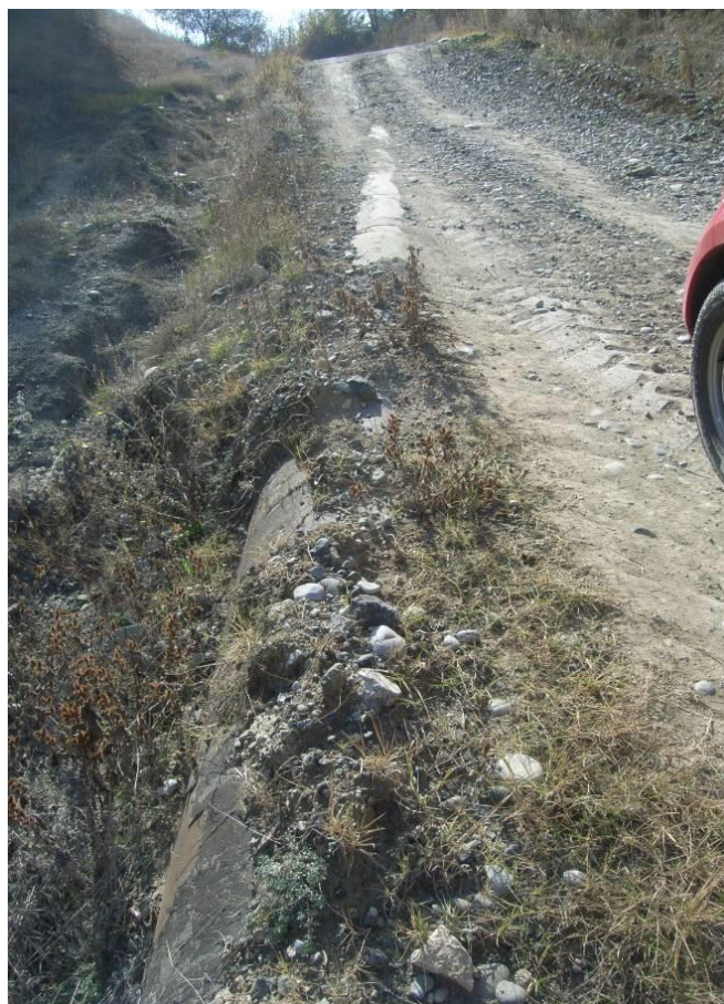
Φώτο 13 : Κεντρικός καταθλιπτικός αγωγός – αποκάλυψη αγωγού σε διαγώνια διέλευση από υφιστάμενο χωματόδρομο στη θέση ΕΓΣΑ 87' X= 296585.5m – Y= 4425143m
