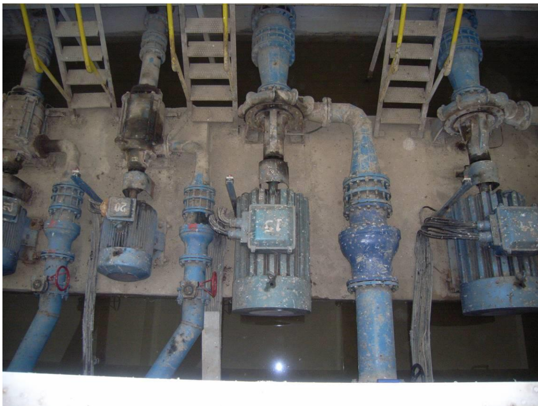
Φώτο 24 : Αντλητικά συγκροτήματα Ζώνης No 3 – αντλία P3M-002 με προβληματική λειτουργία
