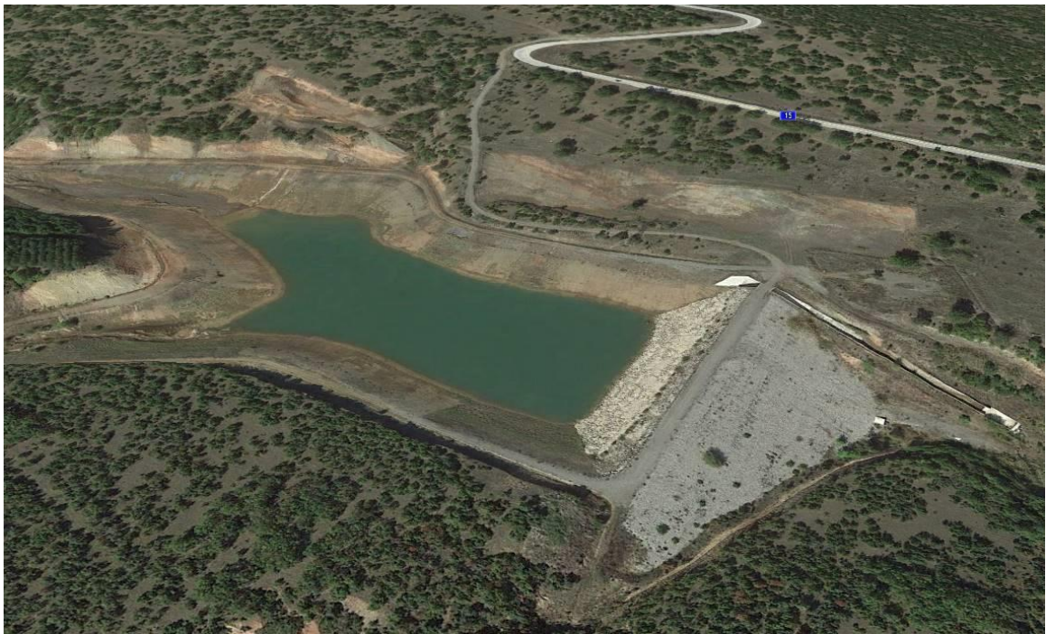
Φώτο 7 : Γεώφραγμα και λιμνοδεξαμενή τροφοδοσίας αρδευτικής Ζώνης Νο 5 (+583m)
