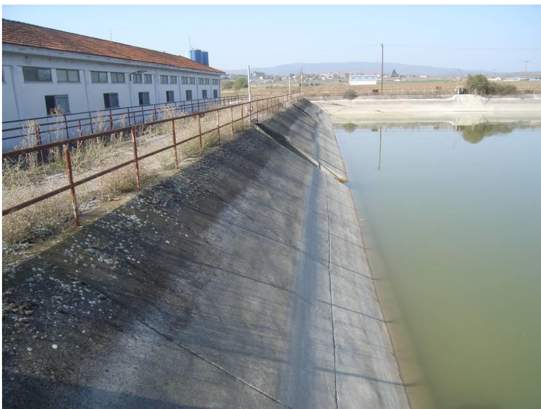
Φώτο 4 : Κεντρική δεξαμενή ημερήσιας εξισορρόπησης – αποθήκευσης (υψόμετρο πυθμένα +459,5m)
