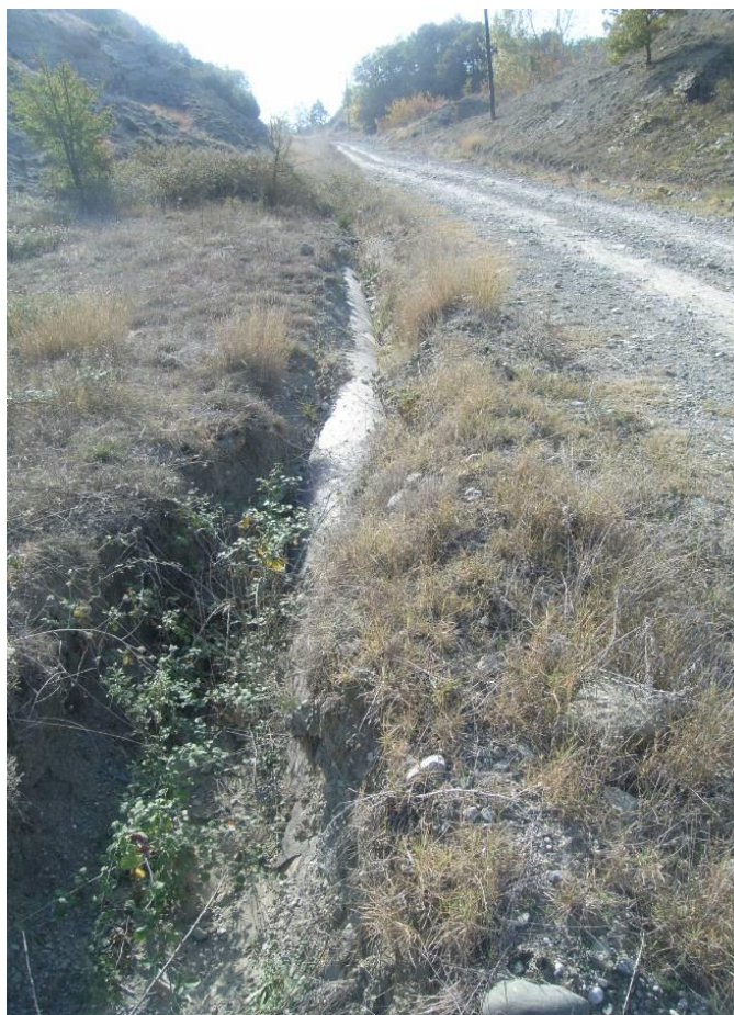
Φώτο 12 : Κεντρικός καταθλιπτικός αγωγός – αποκάλυψη επίχωσης στη θέση ΕΓΣΑ 87' X= 296550.5m – Y= 4425266.4m
