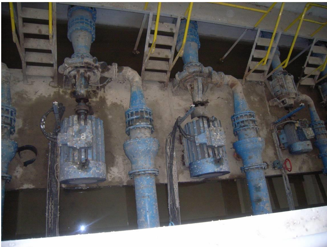
Φώτο 21 : Αντλητικά συγκροτήματα Ζώνης No 2 – αντλία P2M-001 με προβληματική λειτουργία
