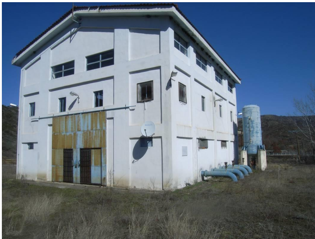
Φώτο 2 : Κεντρικό παρόχθιο αντλιοστάσιο
