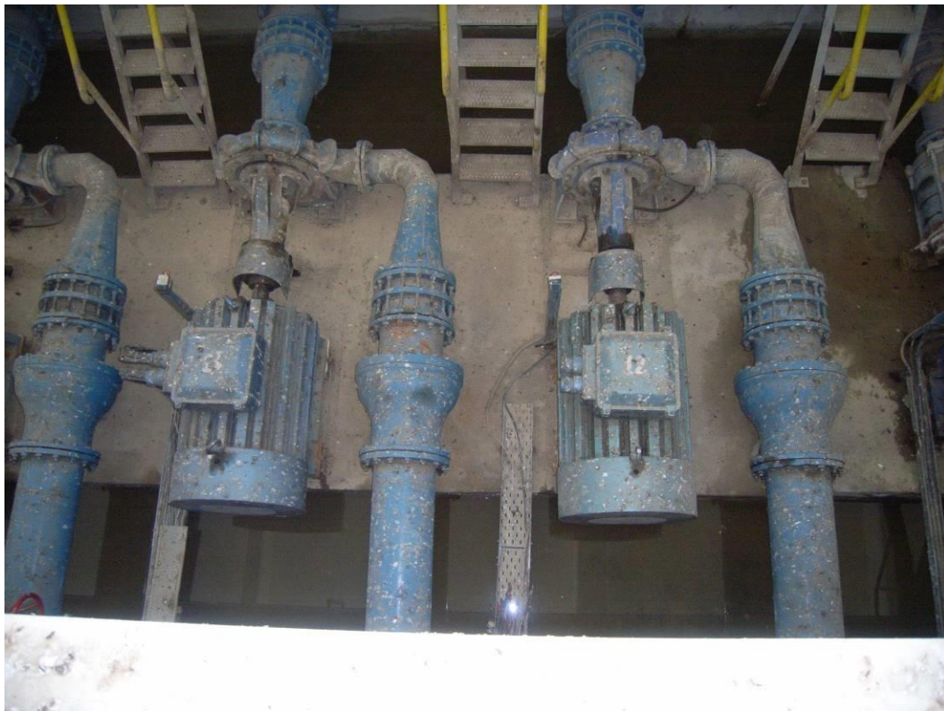
Φώτο 23 : Αντλητικά συγκροτήματα Ζώνης No 3 – κινητήρας αντλίας P3M-004 χωρίς καλώδια
