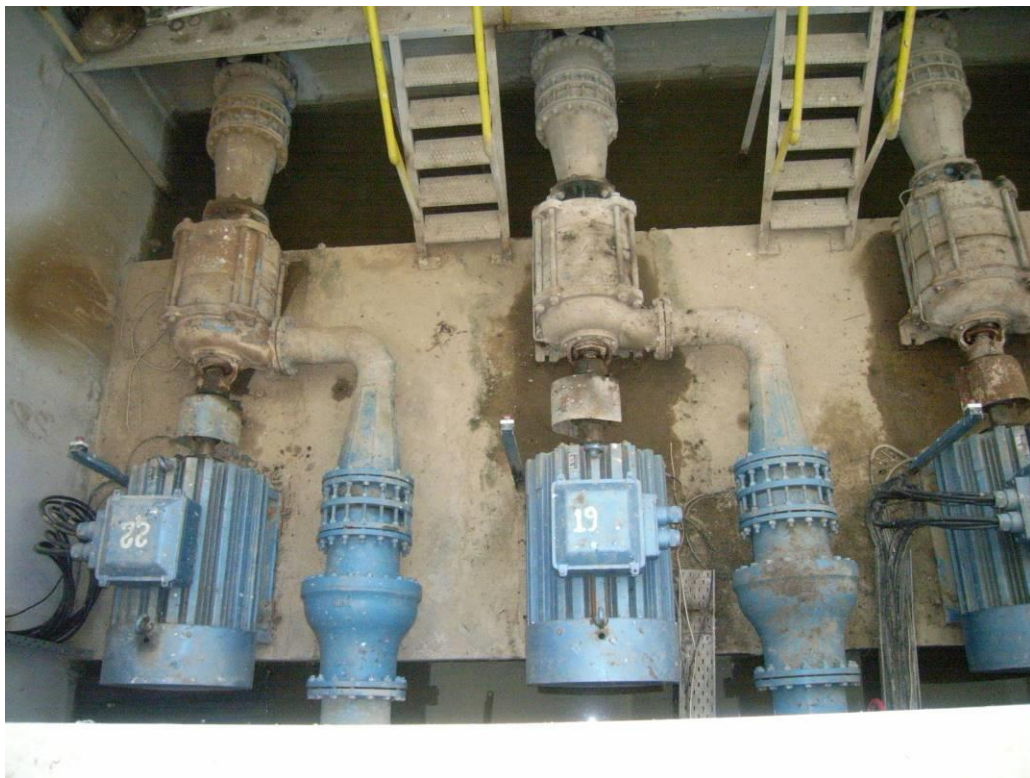
Φώτο 26 : Αντλητικά συγκροτήματα Ζώνης Νο 4 – αντλία P4M-001, P4M-002 & P4M-003 με προβληματική λειτουργία και κινητήρας αντλίας P4M-002 χωρίς καλώδια
