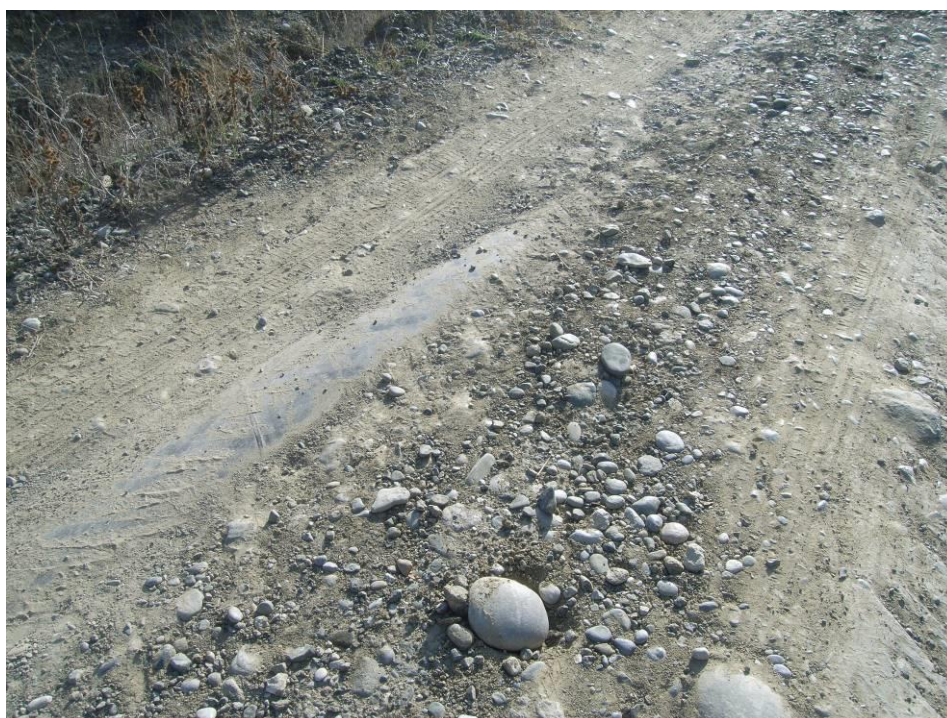
Φώτο 14 : Κεντρικός καταθλιπτικός αγωγός – αποκάλυψη αγωγού σε διαγώνια διέλευση από υφιστάμενο χωματόδρομο στη θέση ΕΓΣΑ 87' X= 296585.5m – Y= 4425143m
