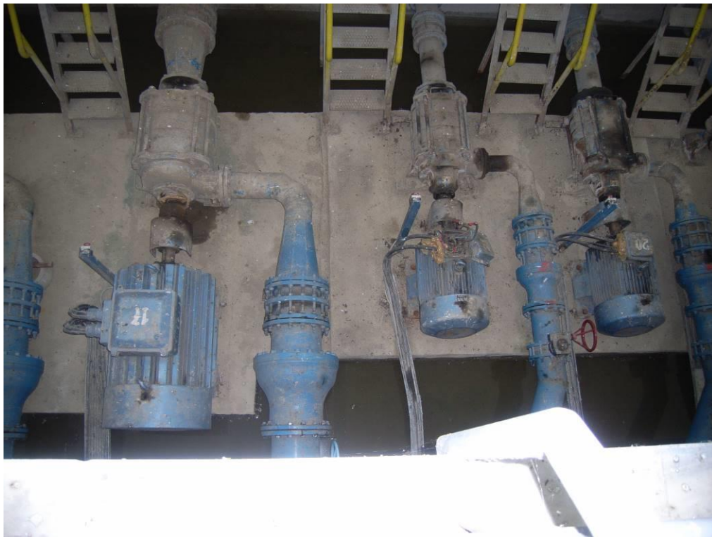
Φώτο 25 : Αντλητικά συγκροτήματα Ζώνης Νο 4 – «καμένος» κινητήρας αντλίας εκκίνησης P4S-001
