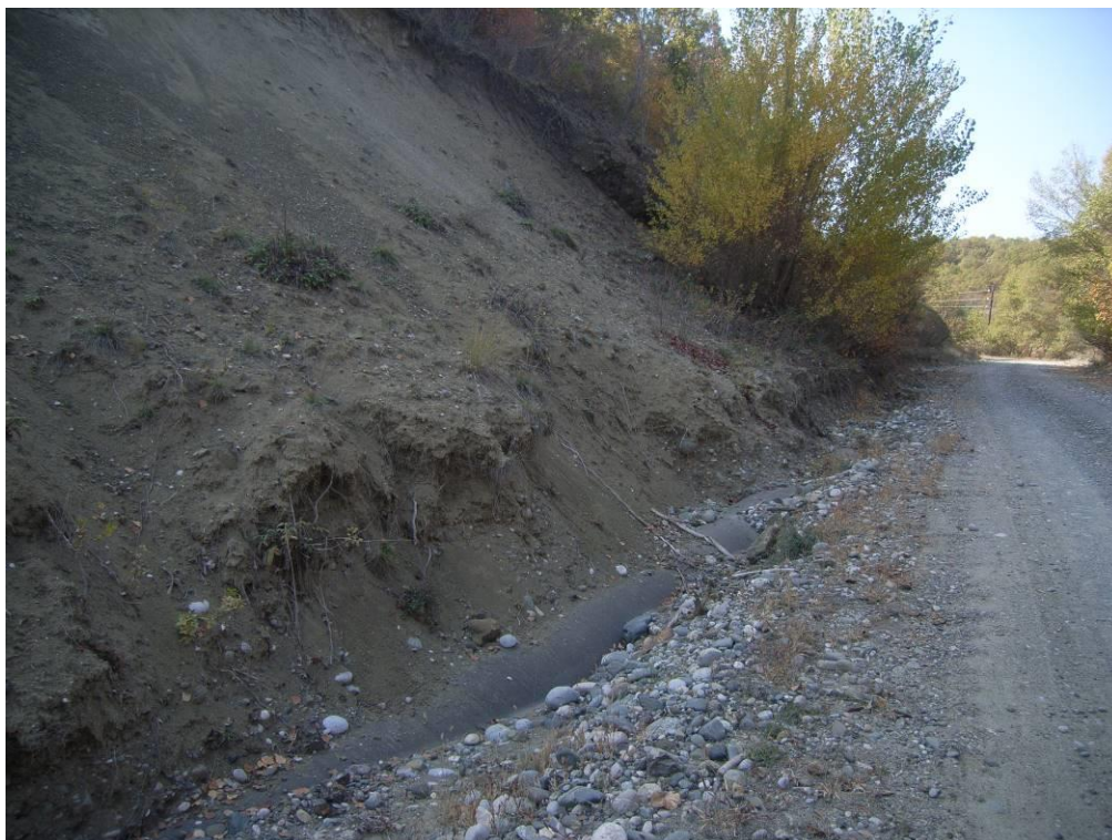
Φώτο 11 : Κεντρικός καταθλιπτικός αγωγός – αποκάλυψη επίχωσης στη θέση ΕΓΣΑ 87' X= 295211.1m – Y= 4427640.1m
